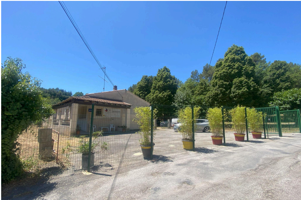
Vue du local depuis la rue Brassens
