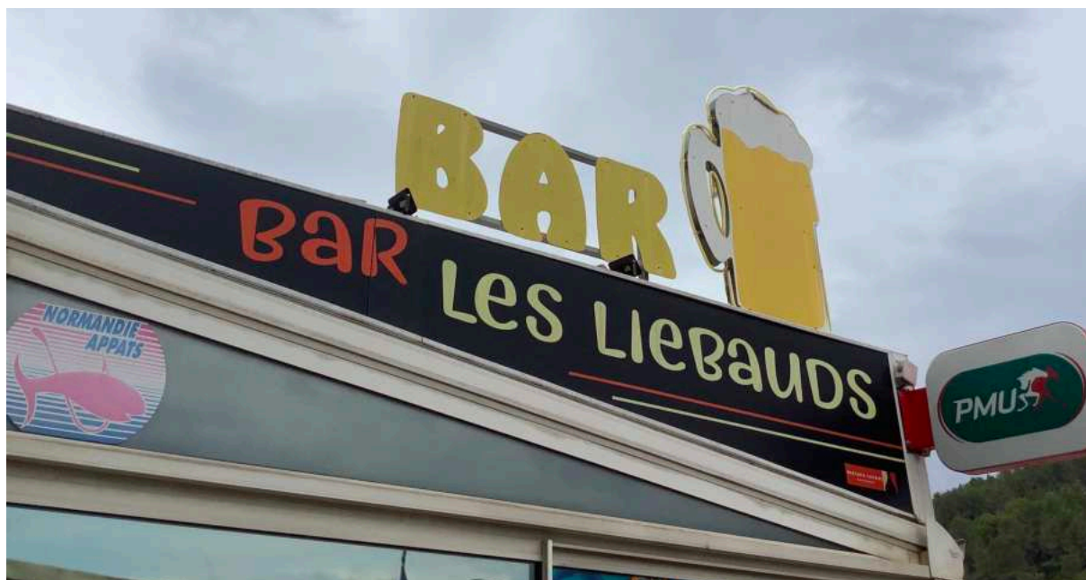
Enseignes sur toiture,, Le Luc-en-Provence, juin 2023.
