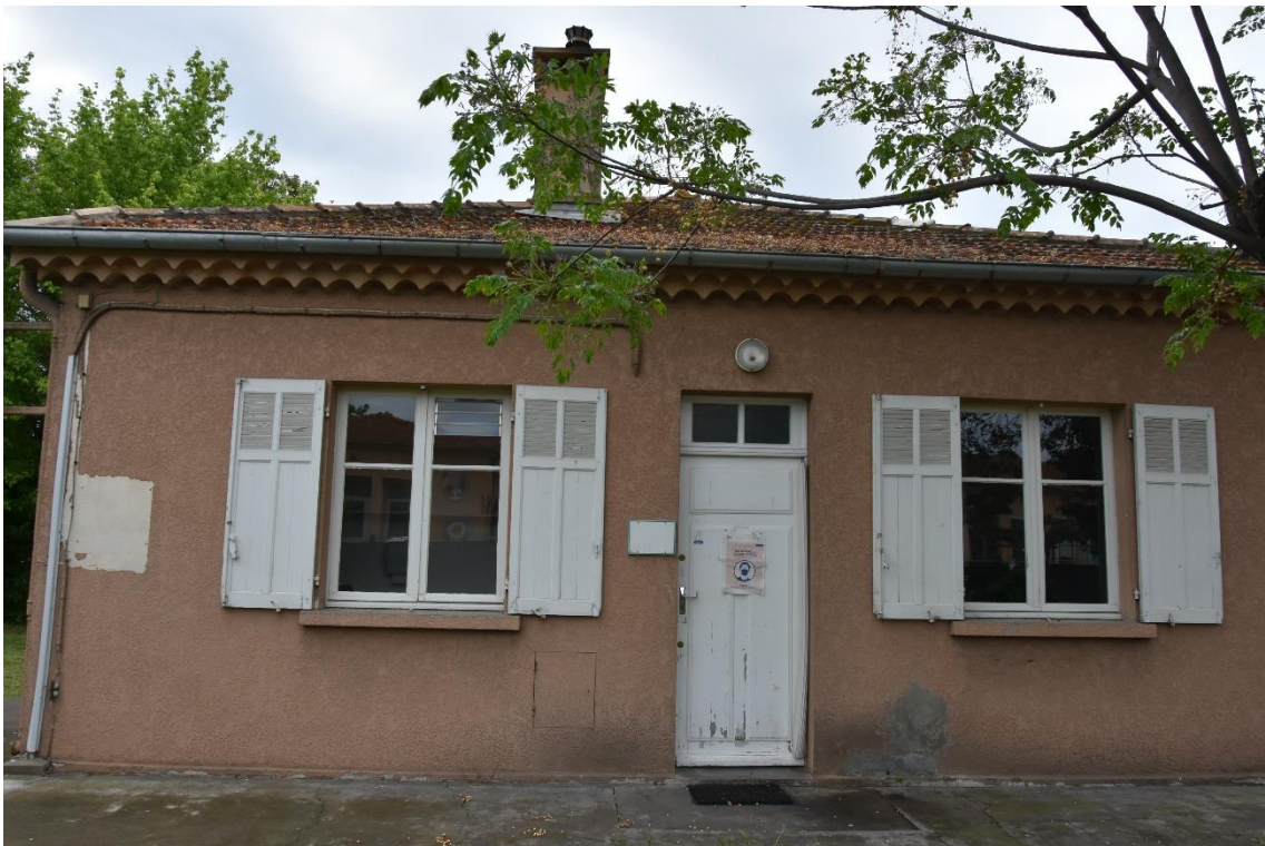
Figure 2 - Entrée du local
